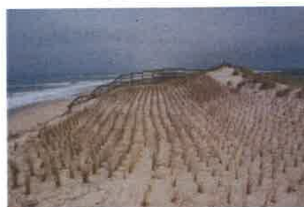
vi) Estabilização dunar
