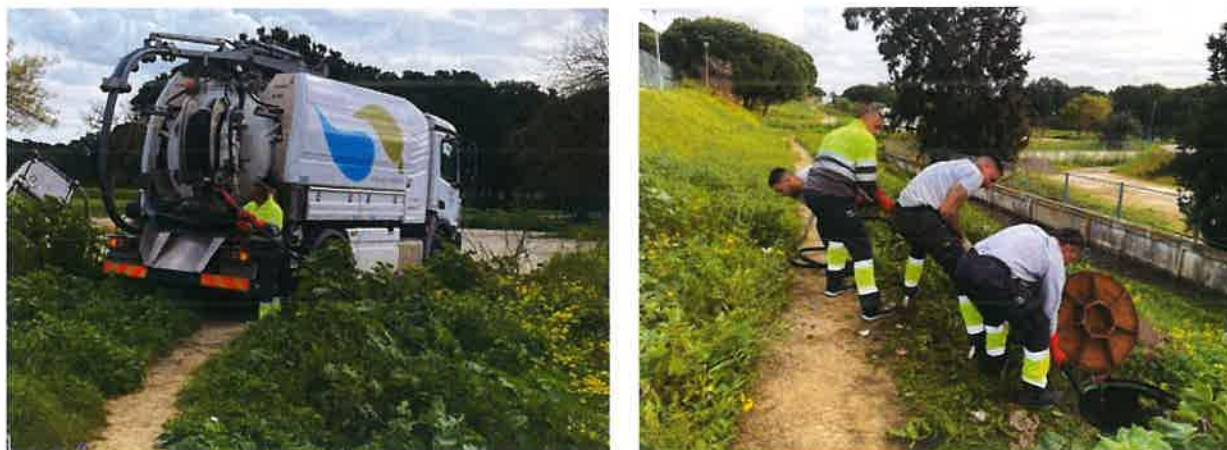
Figura 12 – Desobstrução de coletor
