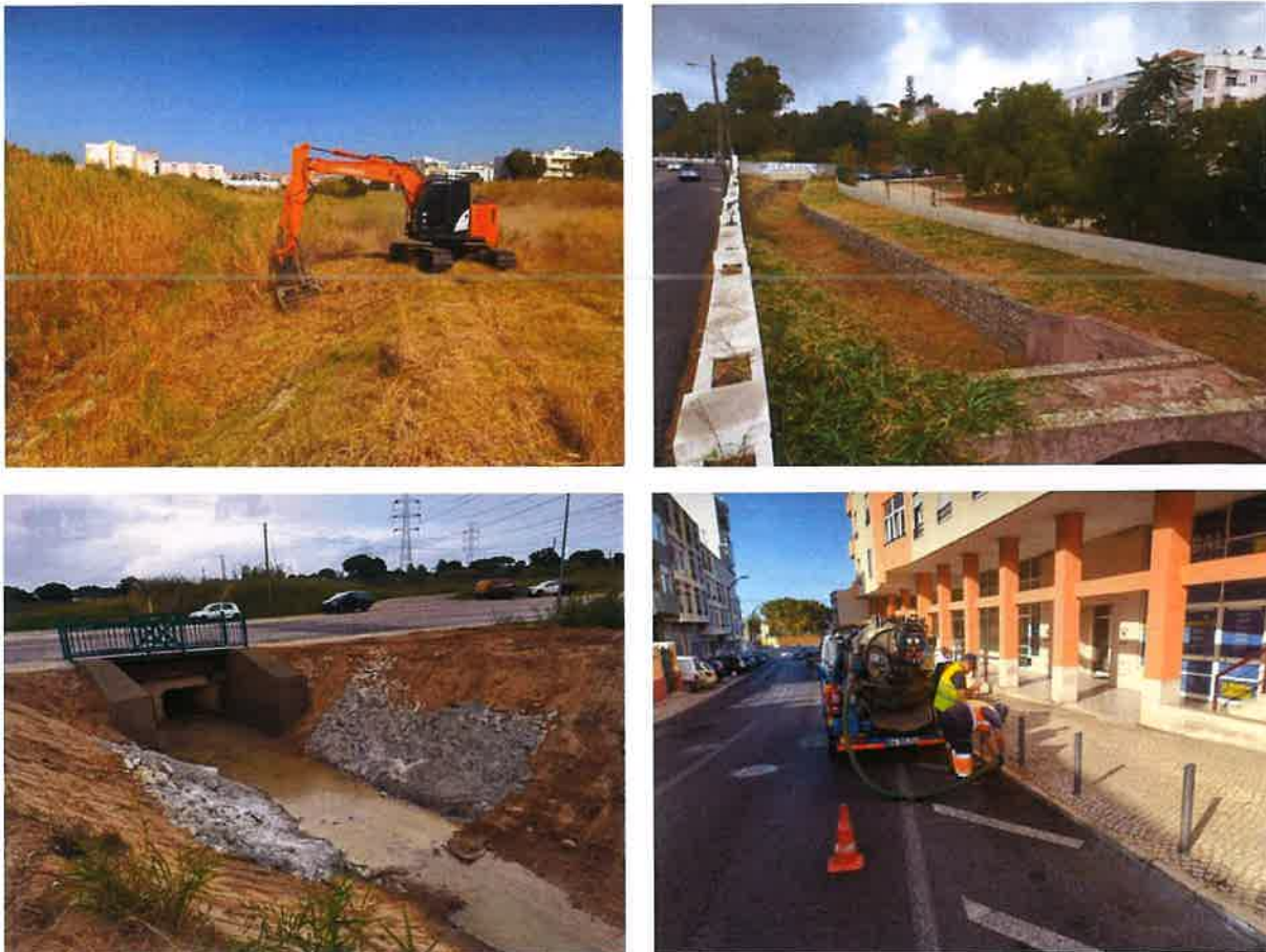
Figura 13 - Limpeza de linhas e água e manutenção da rede canalizada para prevenir as inundações em espaço urbano
