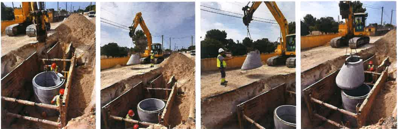
Figura 11 - Construção de conduta de saneamento em Azeitão
