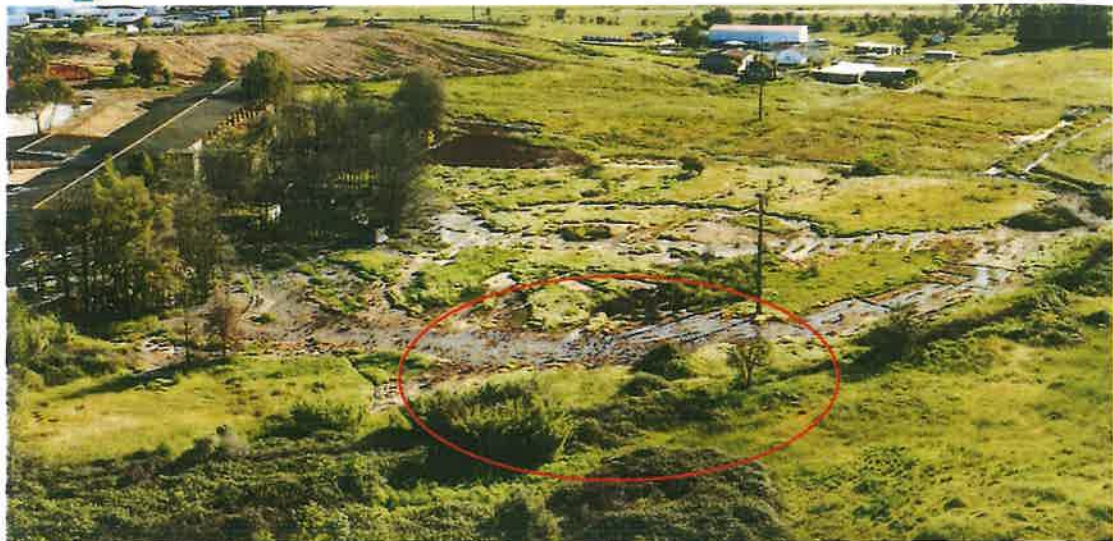
Imagem de 29/04/2025- Descargas antes da mobilização do solo
