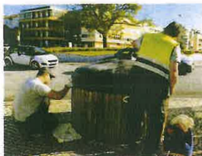
Figura 7 – Manutenção de Contentores
