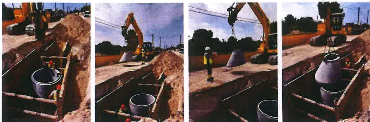
Figura 11 - Construção de conduta de saneamento em Azeitão
