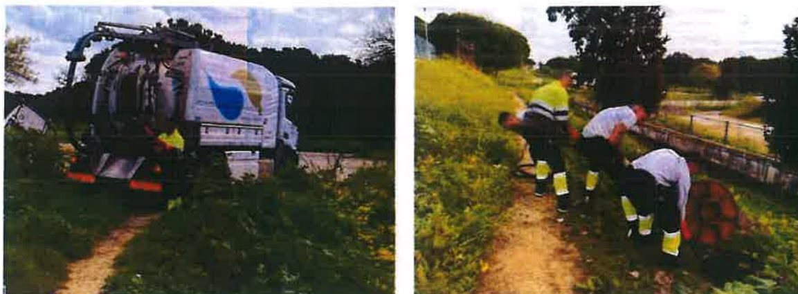
Figura 12 – Desobstrução de coletor
