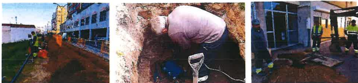
Figura 9 - Reparação de roturas, construção de ramais e substituição de órgãos
