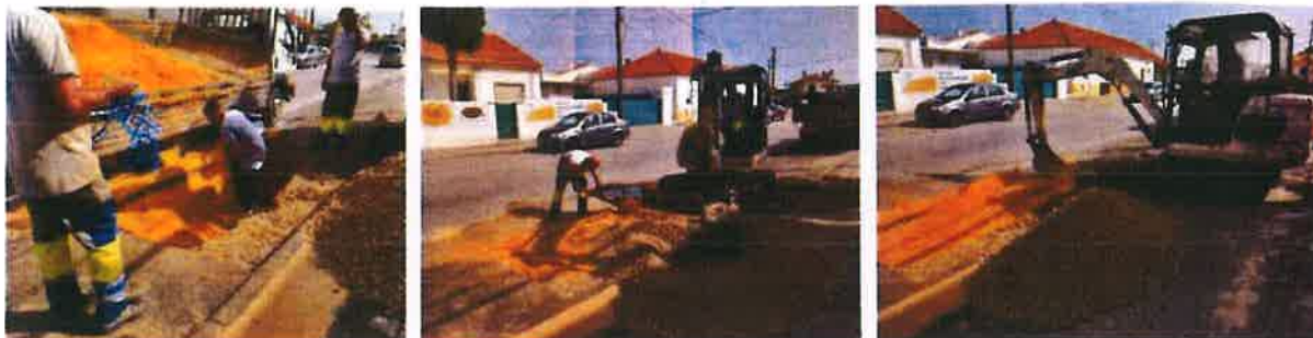
Figura 8 – Equipa dos SMS faz a reparação de uma rotura em Azeitão
