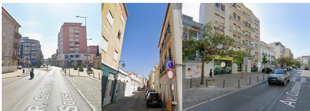
Figura 6 - Levantamento fotográfico dos eixos viários da Rua José Pereira Martins, da Rua João Eloy do Amaral e da Avenida dos Combatentes da Grande Guerra
