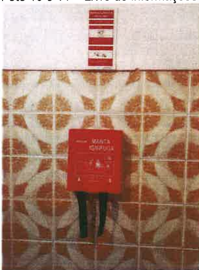
Foto 12 e 13 – Manta Ignífera e extintor sem capacidade regulamentar (2Kg)
