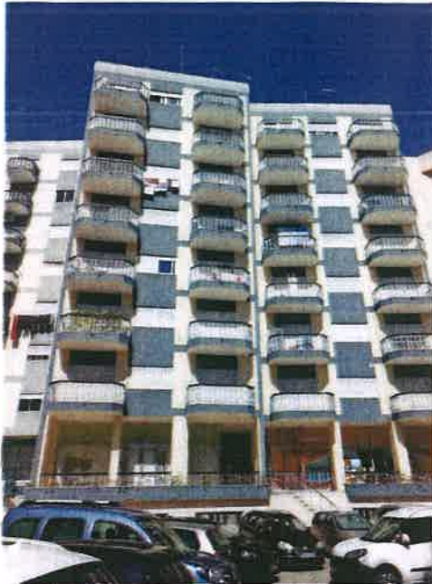
Foto 1 - Edifício onde está instalado o AL
