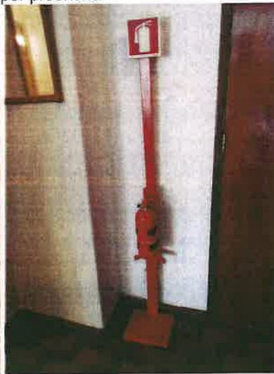
Foto 12 e 13 – Manta Ignífera e extintor sem capacidade regulamentar (2Kg)
