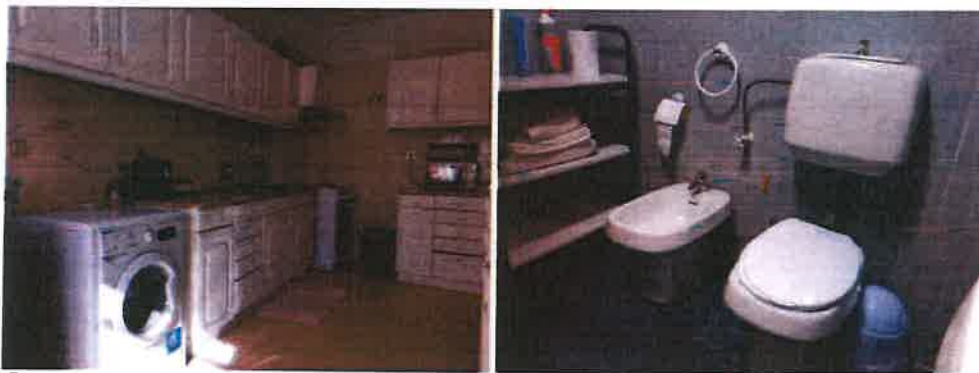
F7 e F8 – Cozinha; instalação sanitária
