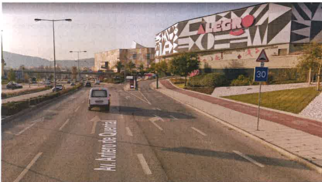
Obras de infraestruturas executadas
