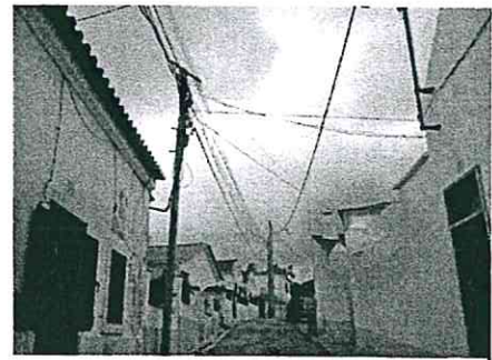
Figura 42 – Rua Engenheiro António Porto Soares Franco
