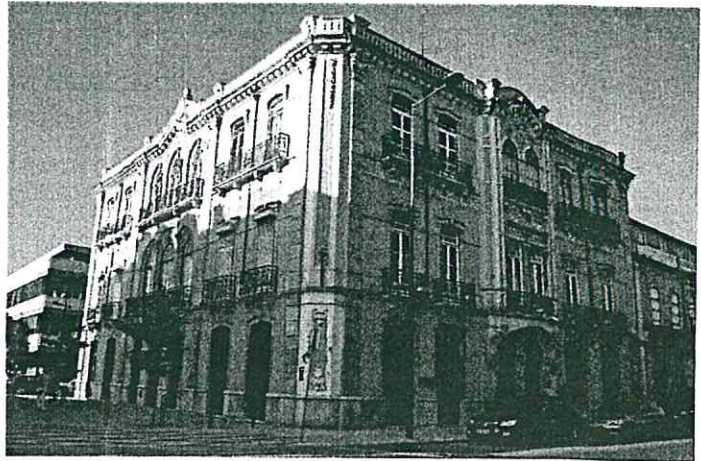
Figura 35 - Edifício do Club Setubalense
