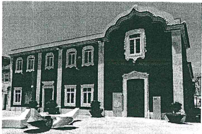
Figura 36 – Recolhimento da Soledade, Casa da Baía
