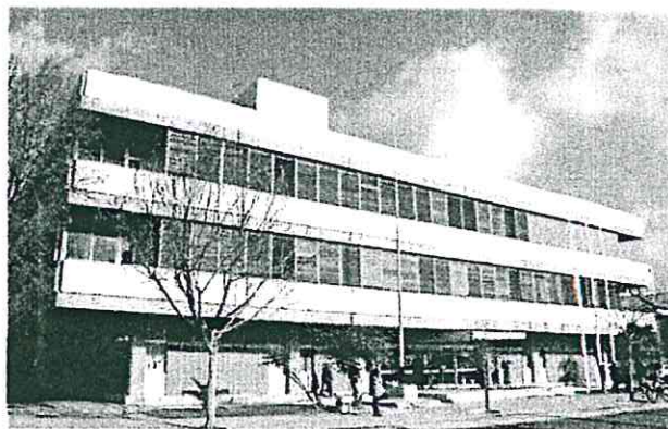
Figura 29 – Edifício do Centro Distrital de Solidariedade e Segurança Social de Setúbal
