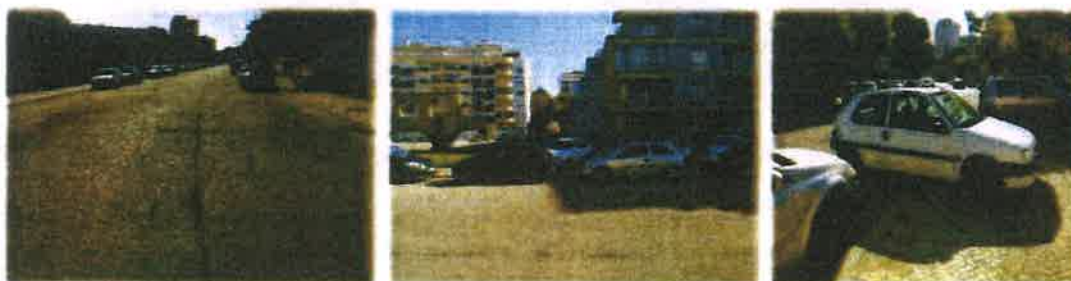
Fig. 3 – Inexistência de linha branca divisória de lugares de estacionamento, desincentivando o estacionamento ordenado e legal, bem como demais marcações rodoviárias
