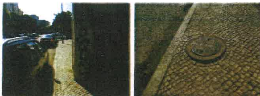
Fig. 5 – Percurso pedonal com menos de 1,2 [m] de largura e remates de caixas de visita sobreelevados ao pavimento existente dificultando a circulação pedonal de pessoas com mobilidade reduzida contrariando o DL 163/2006 de 8 de agosto
