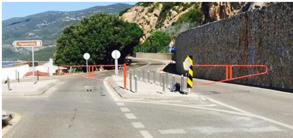
Figura 7 - Cancelas instaladas na Figueirinha.
