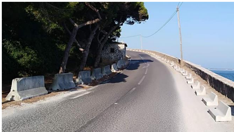
Figura 27 - Impedimentos colocados na EN379-1 - Outão/Figueirinha.
