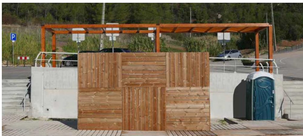
Figura 36 - Sanitários provisórios - Praia de Albarquel.
