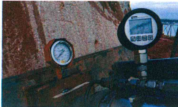
Figura 2.1 – Montagem do sistema de pré-esforço
