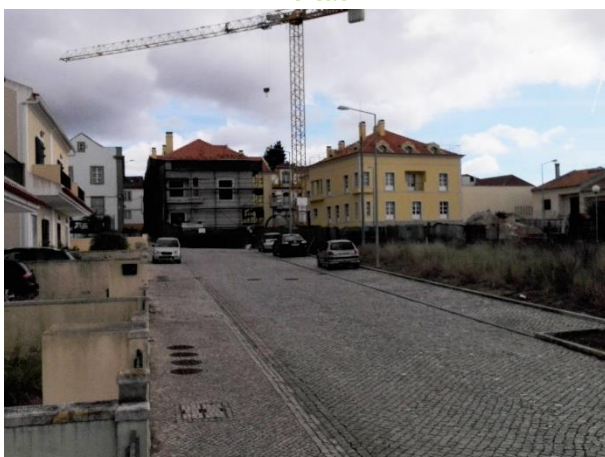
Figura 74 - Praceta do Bairro da Cooperativa de Azeitão
