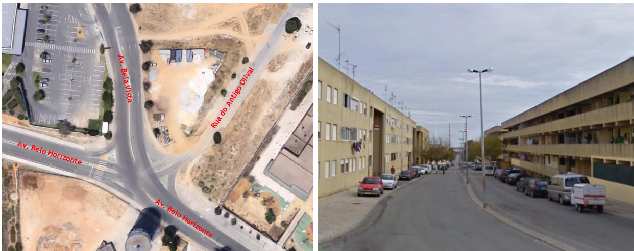
Figura 62 - Entroncamento da Av. Belo Horizonte com a Av. Bela Vista e Rua Antigo Olival e perfil transversal excessivo da Av. Bela Vista
