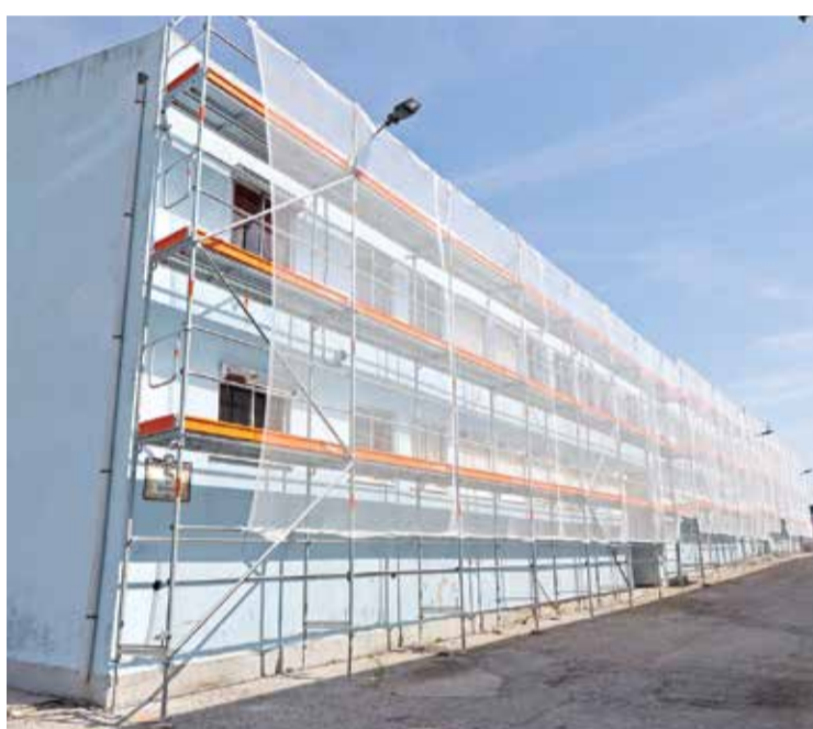
O Forte da Bela Vista também está em obra com trabalhos de reabilitação
