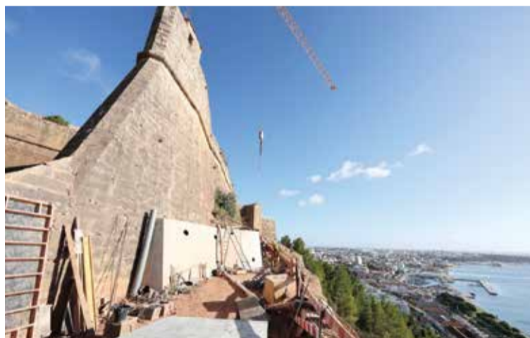
Os trabalhos destinam-se a estabilizar a encosta da antiga fortificação militar
