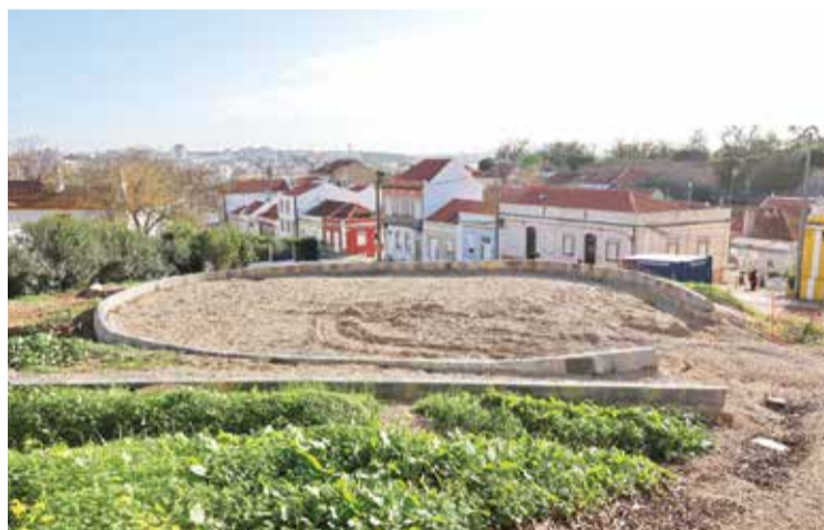
A obra desenvolve-se num espaço descaracterizado, que ganha novas funções
