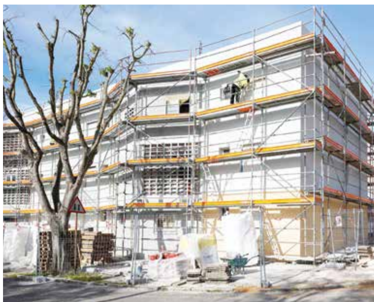
Reabilitação habitacional na Alameda das Palmeiras
