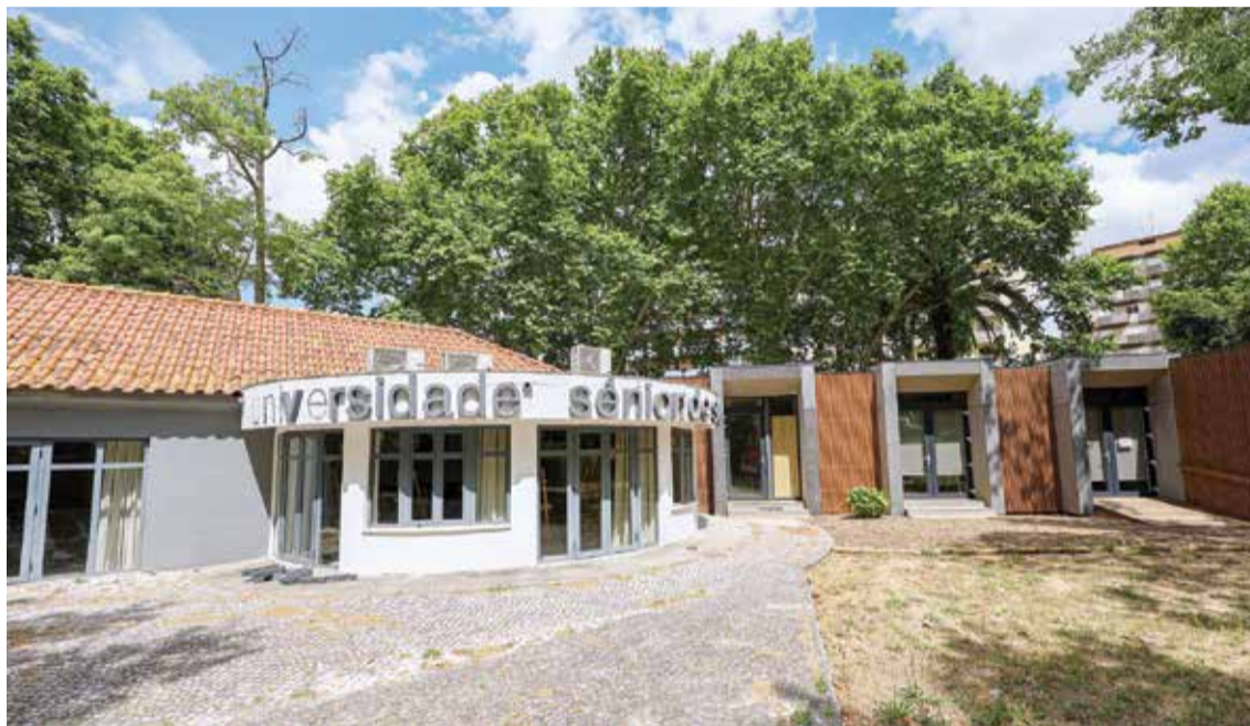
A Câmara Municipal investiu 300 mil euros na ampliação das instalações da Uniseti
