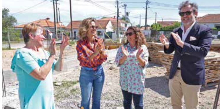
A SIMBA está a construir novas instalações com o apoio do município
