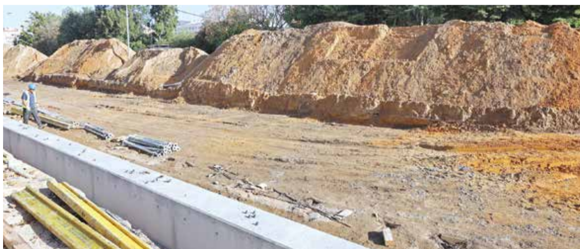
A obra do novo centro escolar já se encontra no terreno
