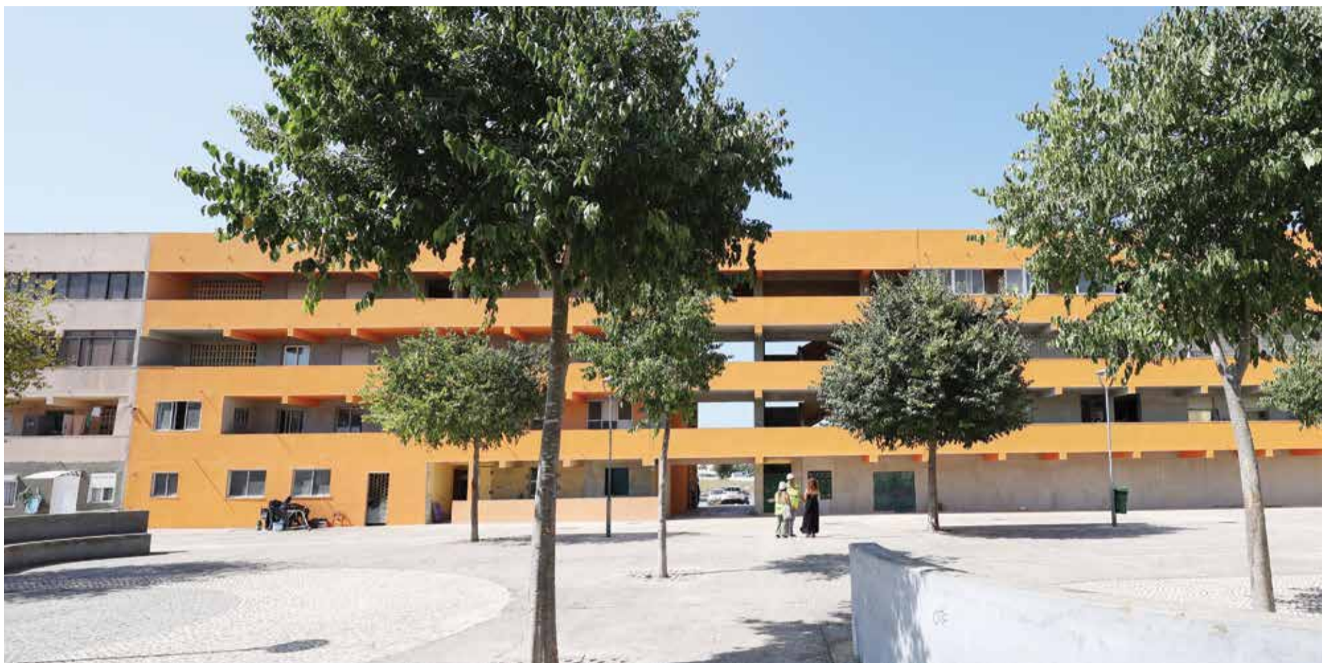
A obra no Bairro da Bela Vista é a mais significativa do plano global de investimentos programados para a reabilitação da habitação pública
