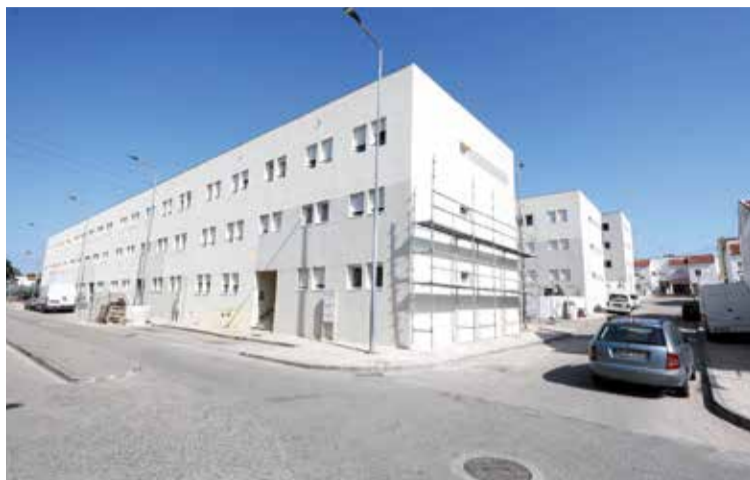
O Bairro das Manteigadas já tem várias obras de reabilitação finalizadas
