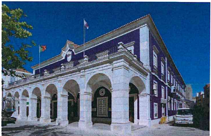
Figura 37 – Edifício dos Paços do Concelho de Setúbal
