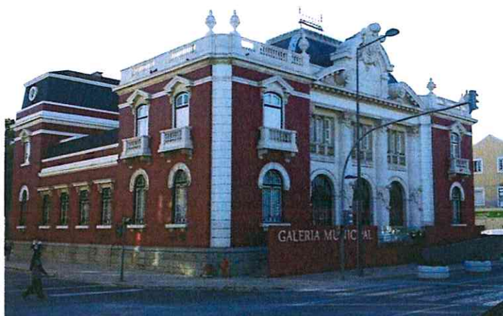
Figura 38 - – Edifício da Agência do Banco de Portugal em Setúbal
