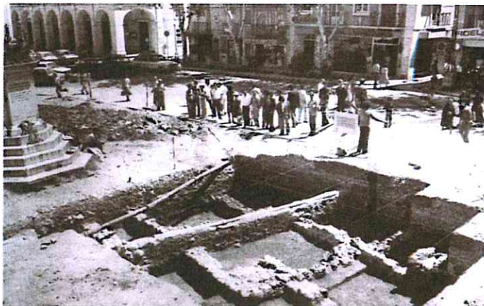
Figura 7 - Escavações na Praça de Bocage. 1957. Arquivo Fotográfico Américo Ribeiro
