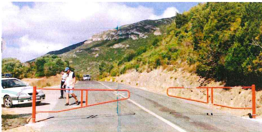
Figura 6 - Cancelas instaladas no Creiro.
