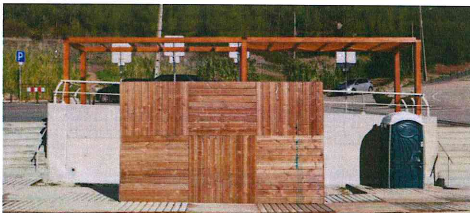
Figura 36 - Sanitários provisórios - Praia de Albarquel.
