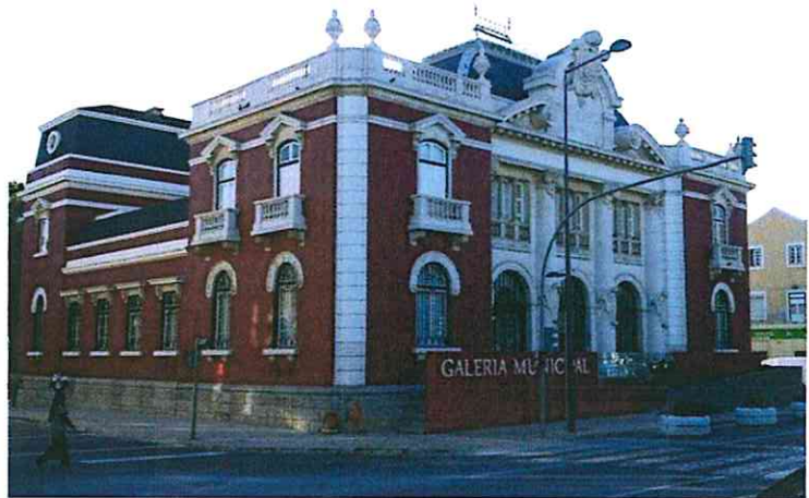
Figura 38 - – Edifício da Agência do Banco de Portugal em Setúbal
