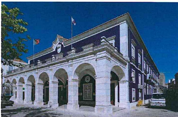
Figura 37 – Edifício dos Paços do Concelho de Setúbal
