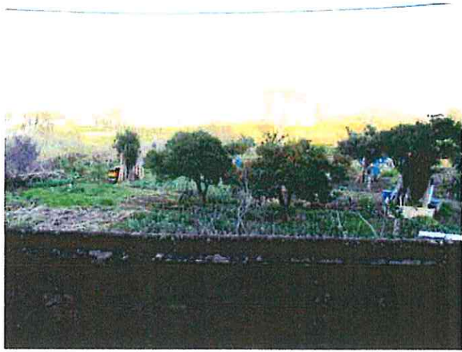
aspecto de um limite ponte
