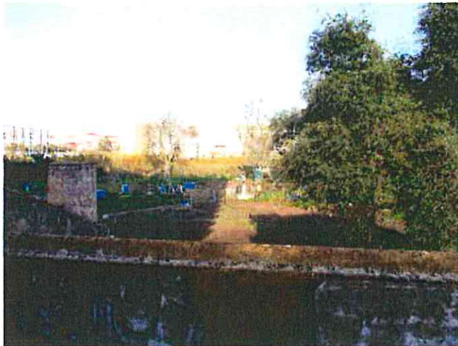
muro de pedra
