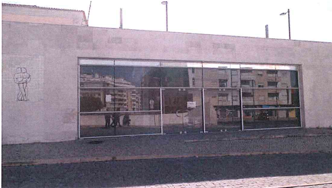
Figura 12 – Vista atual do acesso à futura zona de bilheteiras e apoio ao público
