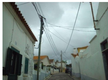
Figura 42 – Rua Engenheiro António Porto Soares Franco
