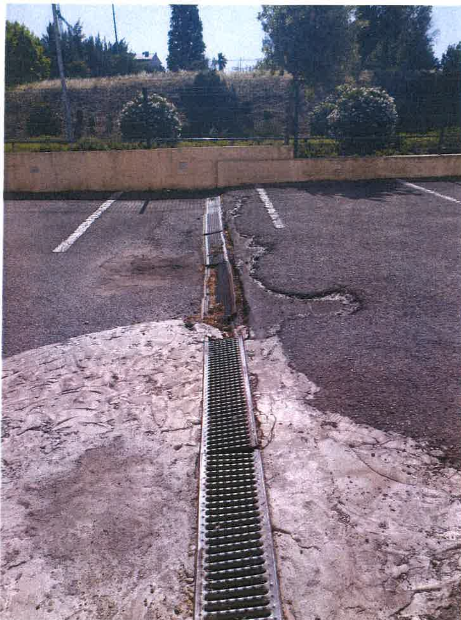
(foto 5) – Grelha de drenagem pluvial e pavimento do Estacionamento descoberto – zona comum
