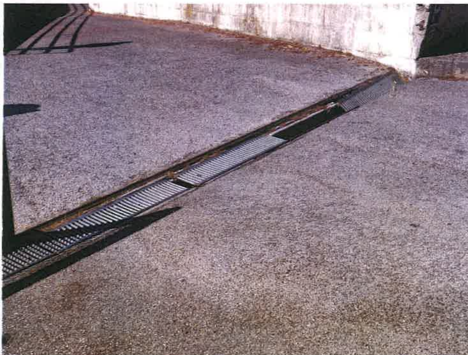
(foto 7) - Grelha de drenagem pluvial – Entrada do Estacionamento descoberto – zona comum
