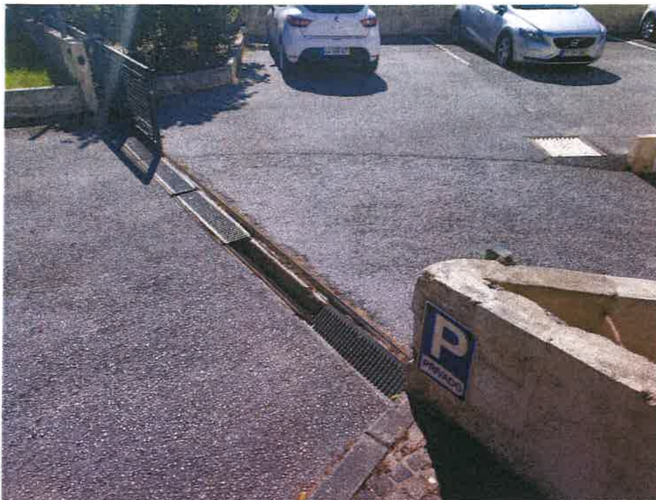
(foto 6) - Grelha de drenagem pluvial – Entrada do Estacionamento descoberto – zona comum
