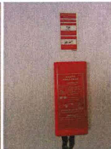
Foto 4, 5 e 6 – Extintor (por afixar) e manta ignífuga (colocada atrás da porta da cozinha)
