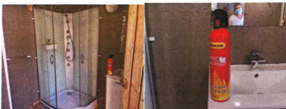
Fotos 9 e 10 – IS do quarto1 e extintor
