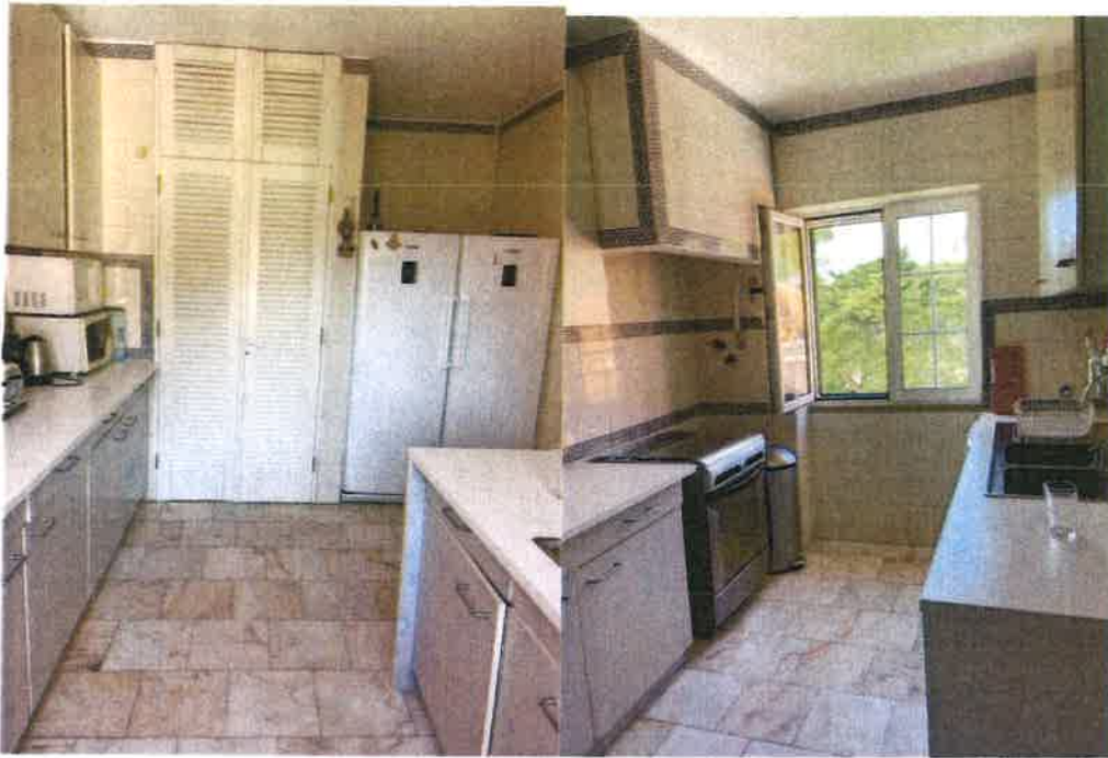
Foto 11 e 12 – Cozinha; Manta não fixada
