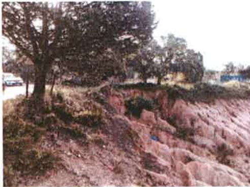
F 5: Evidências da erosão provocada pela escorrência de águas da chuva, no limite do caminho com o declive da escavação, que formam uma barreira.
