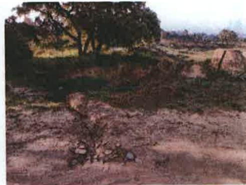
F 4: Evidências da erosão provocada pela escorrência de águas da chuva, no caminho que serve de zona de passagem entre as propriedades.
