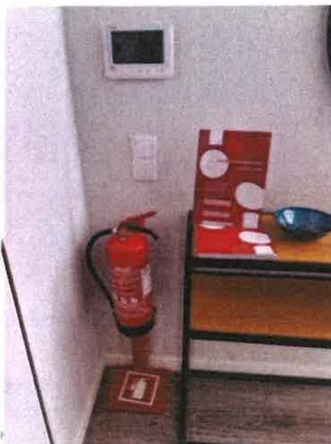
Foto 9 e 10 – Caixa de 1ºs Socorros e Extintor não fixado
