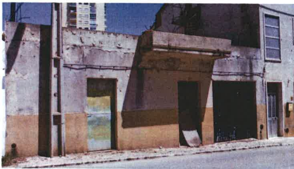
Foto nº 2 - Edifício, com os nºs de policia nºs 18 e 20
