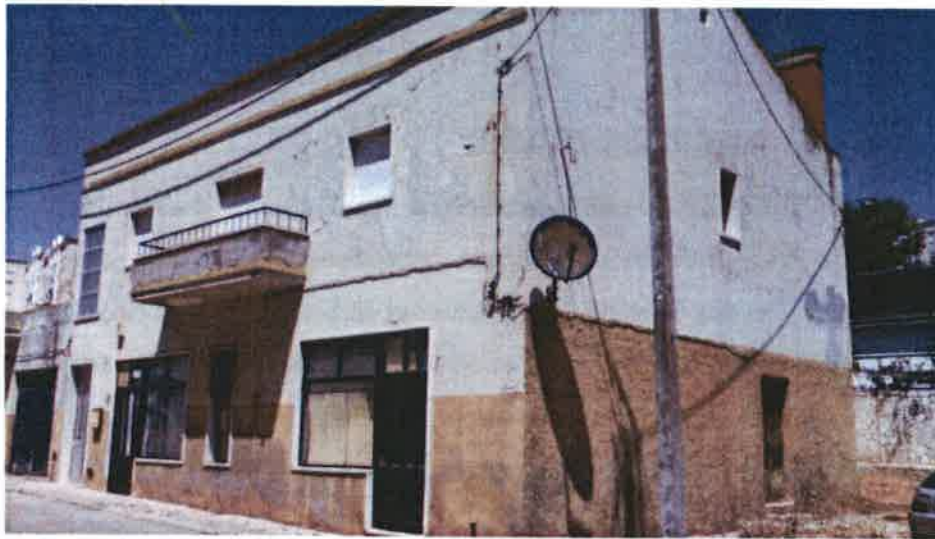
Foto nº 1 - Edifício, com os nºs 12, 14 e 16
