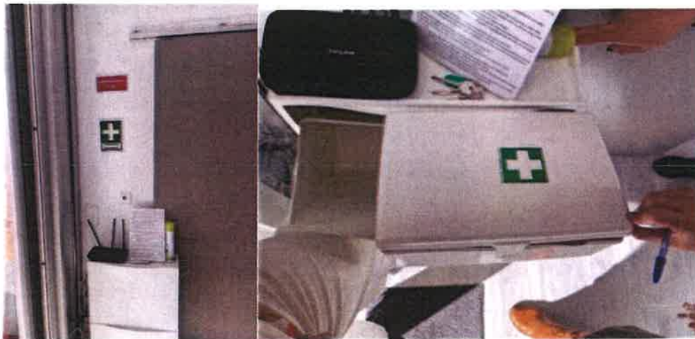
Foto 8 e 9 – Caixa de 1ºs Socorros e simbologia
