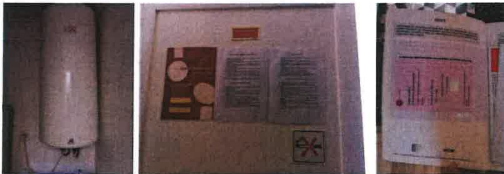
F7, F8 e F9 – Termoacumulador eléctrico; folha de rosto do Livro de Reclamações; Livro de Reclamações
