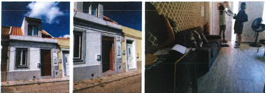
F1, F2 e F3 – Fachada principal; fachada principal (entrada e placa identificativa); sala/cozinha
