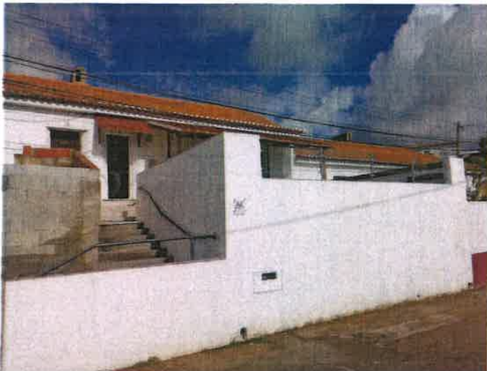
Foto 1 - Edifício onde está instalado o AL
