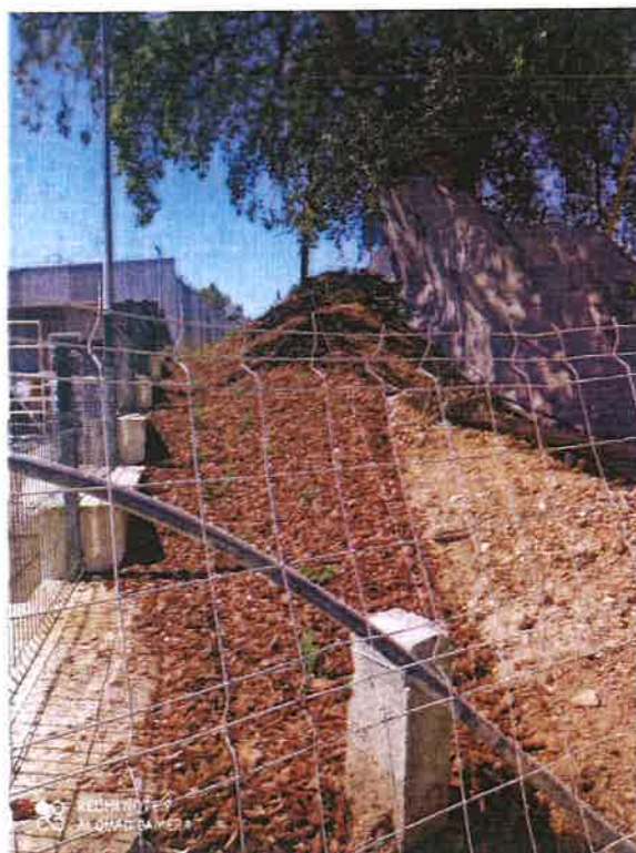
(foto 16) – Espaços verdes – R. Vieira da Silva – Cais de descarga
