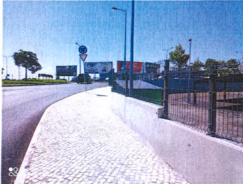
(foto 3) – Arruamento e passeio na Av. Mestre Lima de Freitas/EM542
