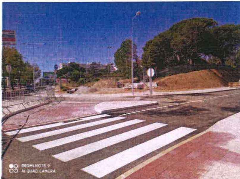
(foto 8) – Arruamentos – Via de ligação Fase 0/EM542
