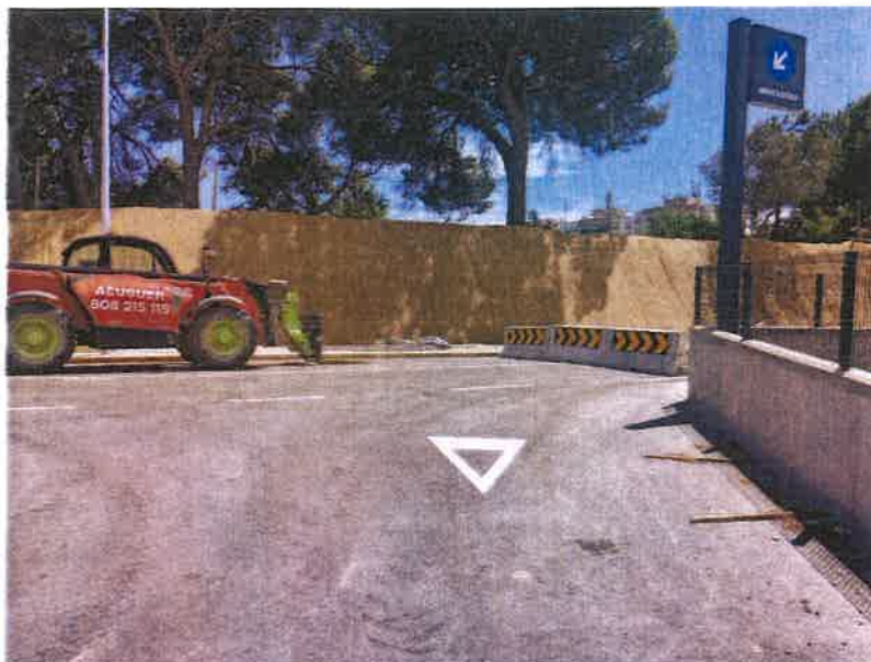
(foto 9) – Via de ligação – Fase 0 - Acesso Sul – sinalização horizontal
