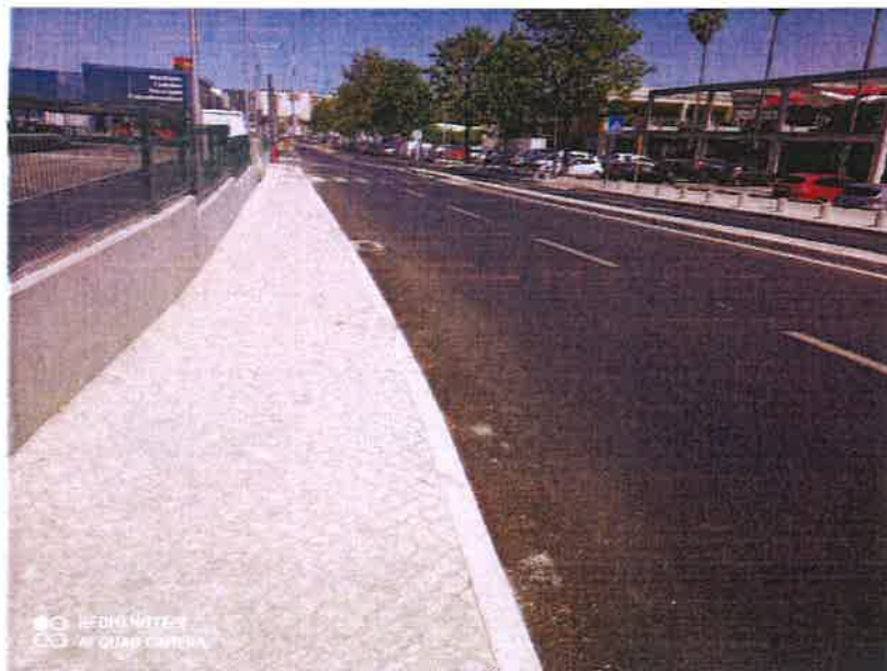
(foto 2) - Arruamento e passeio na Av. Mestre Lima de Freitas
