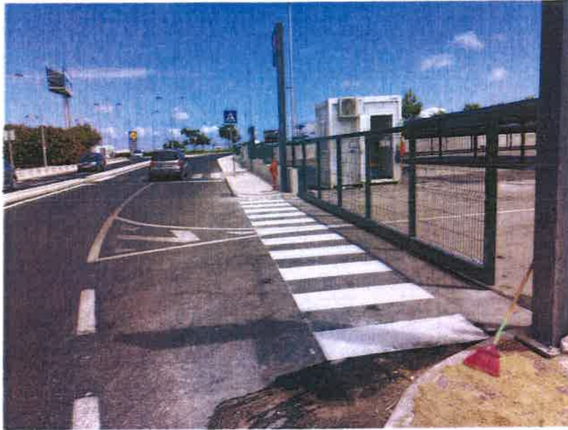
(foto 11) – Acesso Norte – Av. Mestre Lima de Freitas – sinalização horizontal
