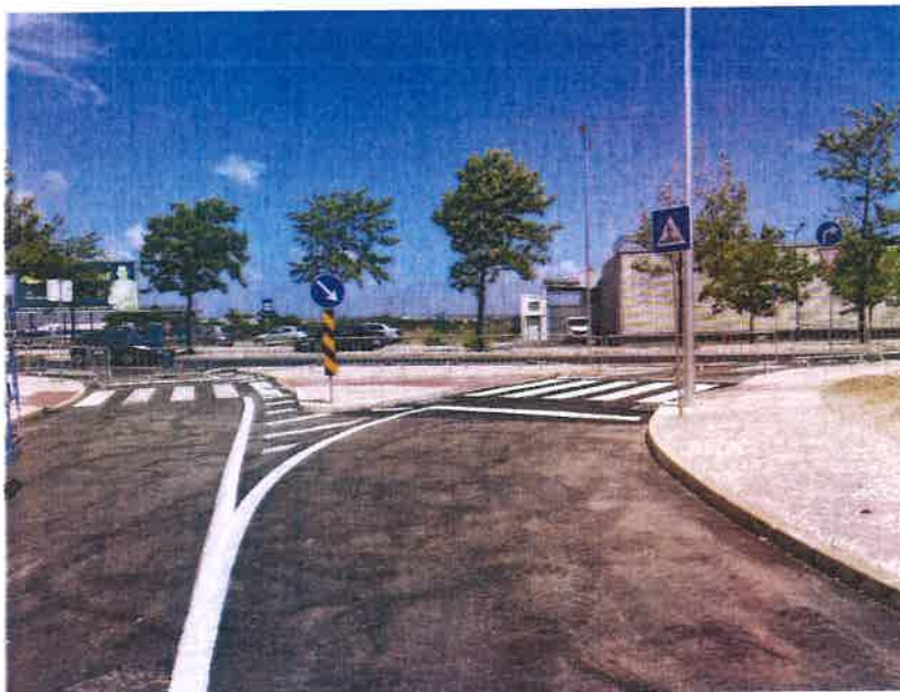
(foto 15) – Via de Ligação – Fase 0 /EM542 – sinalização vertical
