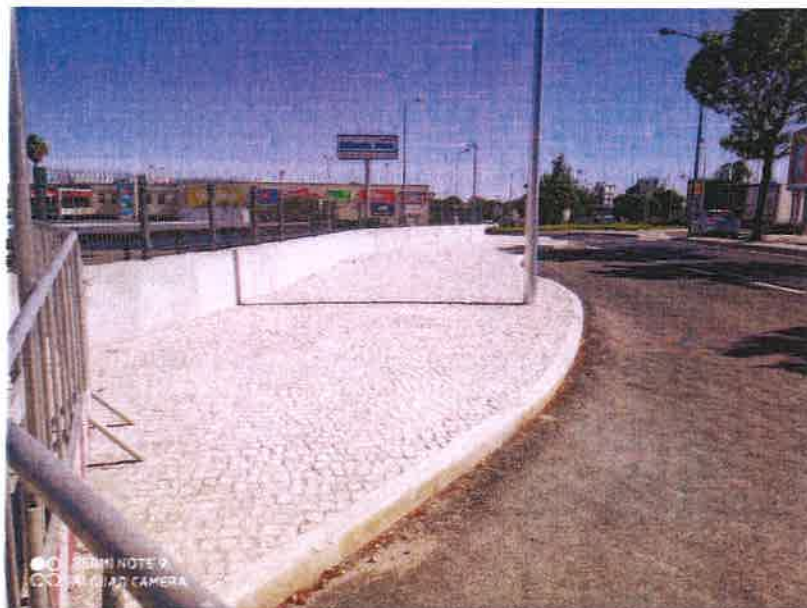
(foto 6) – Arruamentos e passeios - EM542/Via de ligação Fase 0
