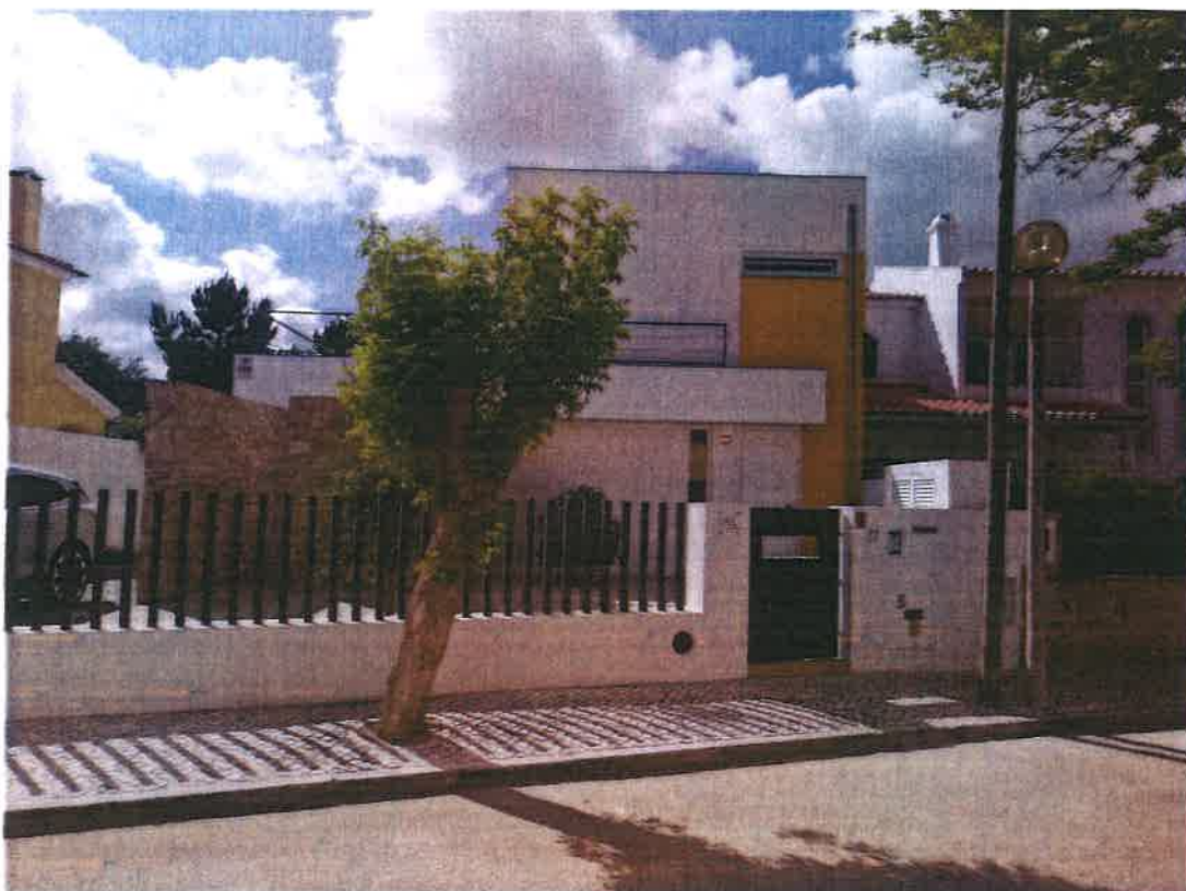
Foto 1 - Edifício onde está instalado o Alojamento Local
