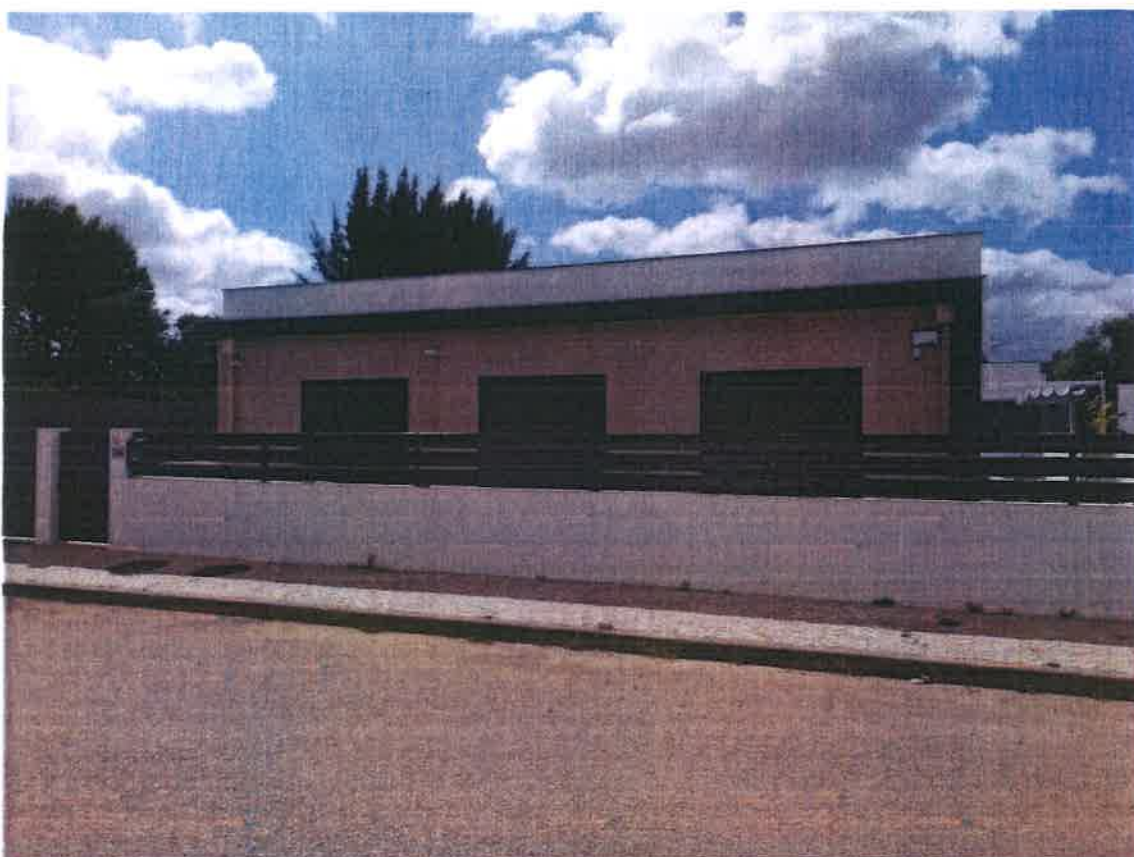
Foto 1 - Edifício onde está instalado o Alojamento Local
