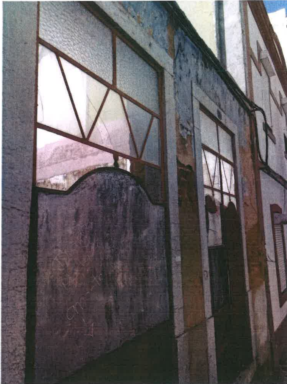
(foto 3) – Fachada Principal – Pormenor de vãos
