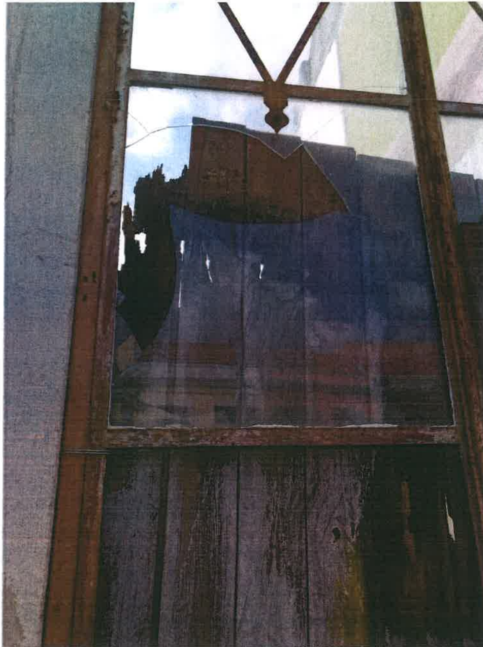
(fot 4) – Fachada Principal - Pormenor de vãos
