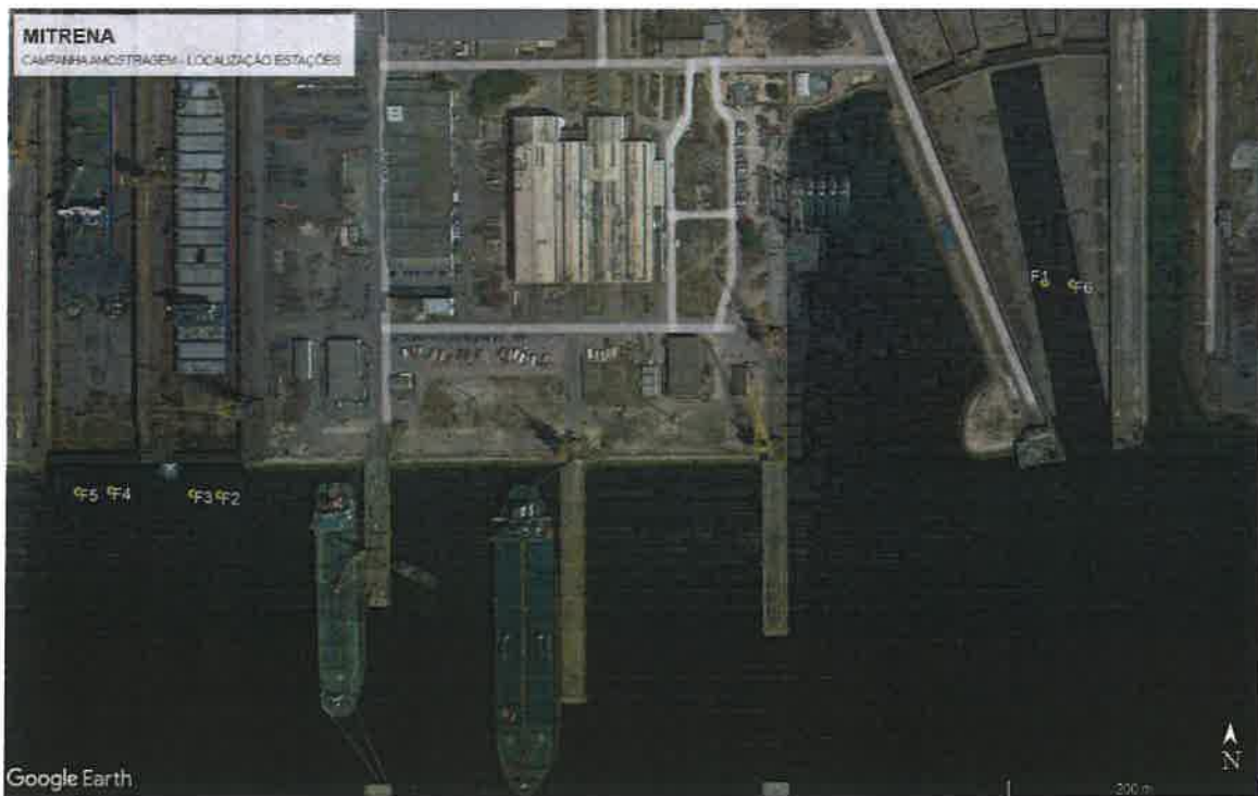
Figura 1 – Localização dos pontos de amostragem realizados na orla marítima do Estaleiro da Mitrena, entre Cais do Aço e Eclusa (in Google Earth).
