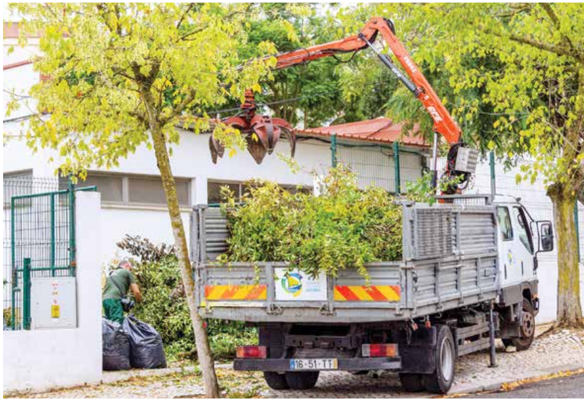
Diversas intervenções beneficiaram os espaços escolares
