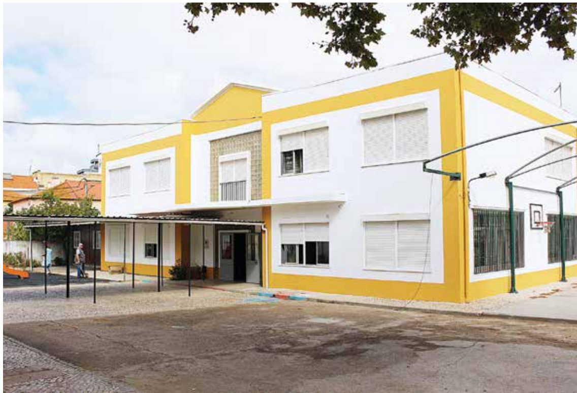
O edifício mais recente da EB do Bairro N.º Sr.ª da Conceição foi beneficiado
