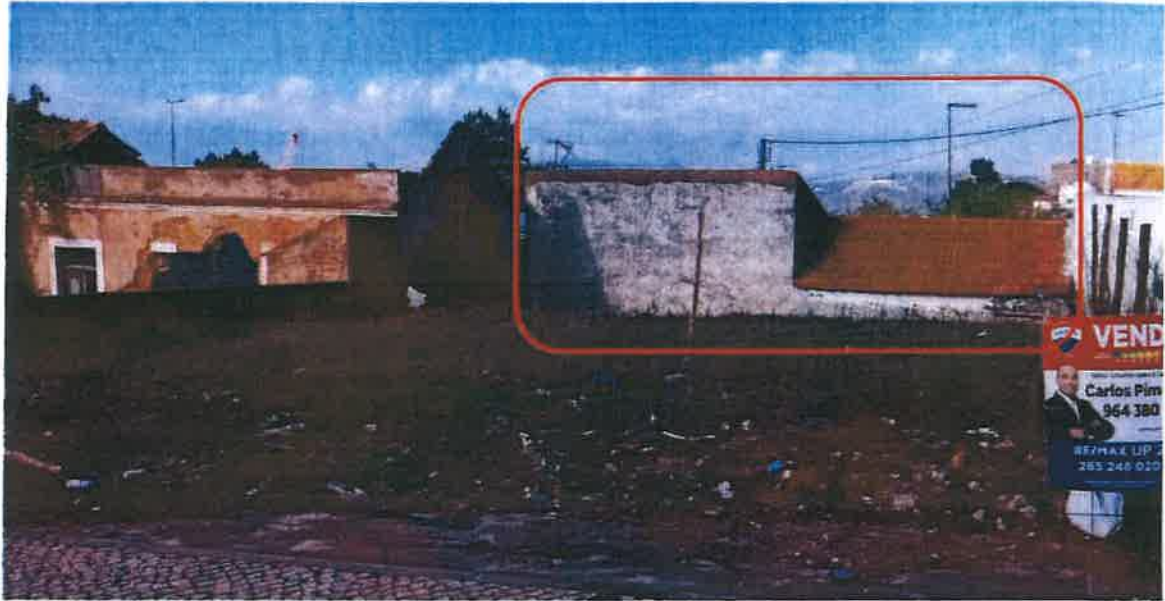
Foto 1 - Vista da R. Rodrigo Ferreira da Costa, n.º 5
