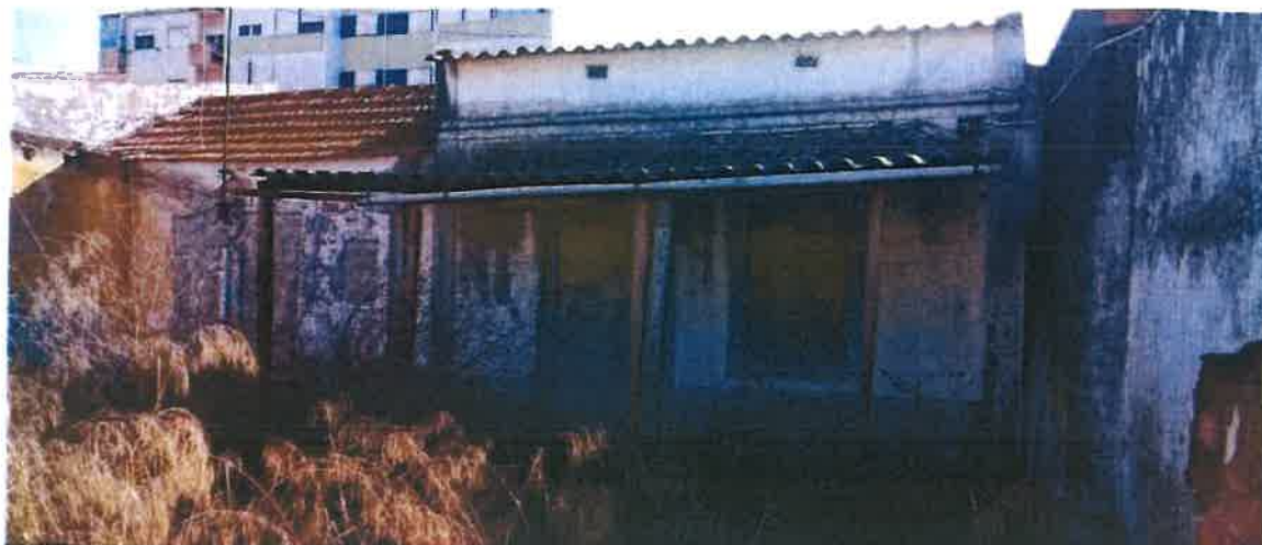
Foto 3 – Alçado posterior - Edifício
