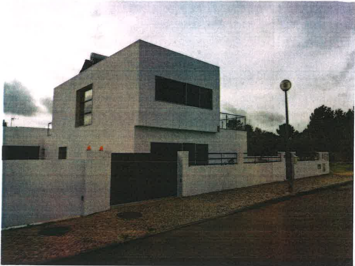
Foto 1 - Edifício onde está instalado o AL
