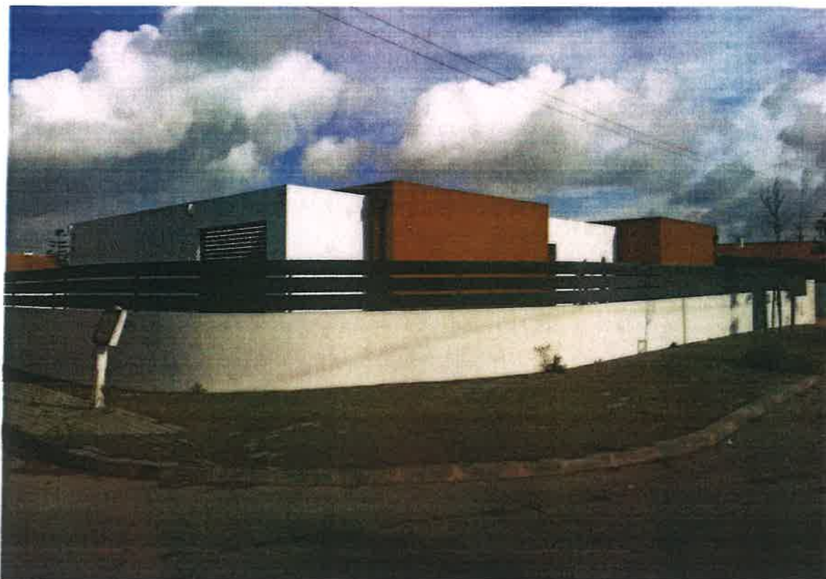
Foto 1 - Edifício onde está instalado o AL
