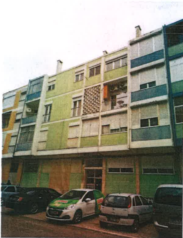
Foto 1 - Edifício onde está instalado o AL
