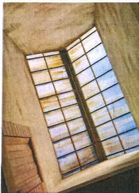
Foto 4 – Claraboia na zona da escada
