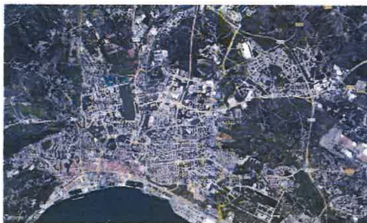
Fotografia Aérea – Enquadramento na região
