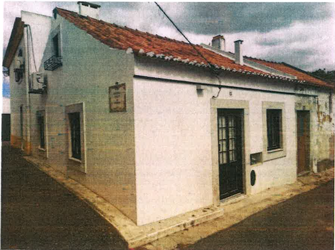
Foto 1 - Edifício onde está instalado o Alojamento Local
