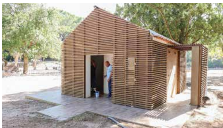
A recuperação das casas de banho foi um dos melhoramentos realizados
