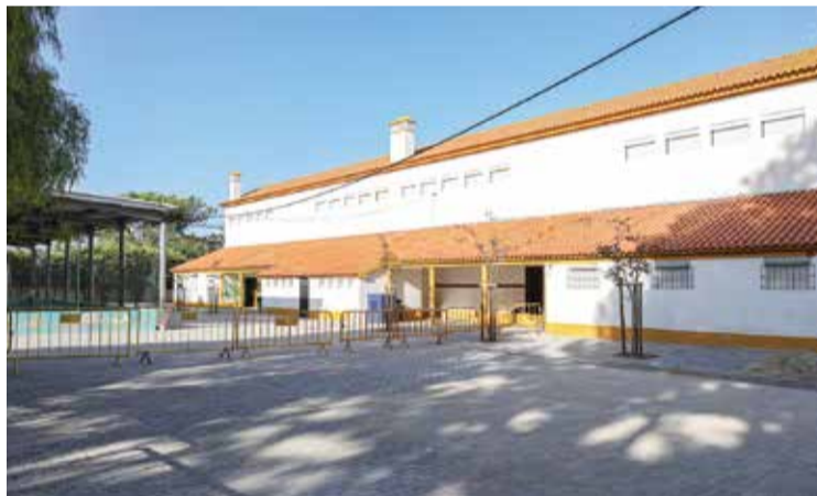
Novo pátio na EB do Casal das Figueiras, na União das Freguesias de Setúbal
