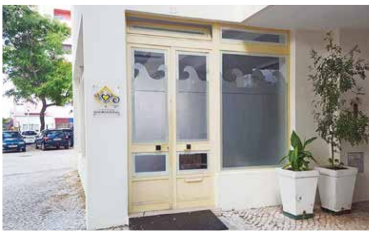
O Polo de Santa Maria reabre com mais oferta após obras de modernização
