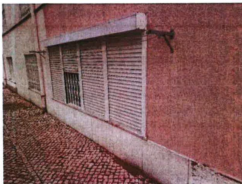
Foto 1 – Estendal de roupa da Fração C de edifício sito na Rua Cidade de Debrecen n.º 20 (confinante com a Praceta de Olivença)
