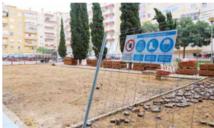
As obras começaram pela Praceta Quinta do Tavares
