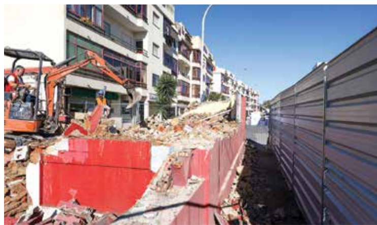
A demolição do edifício pôs fim a um problema a nível rodoviário
