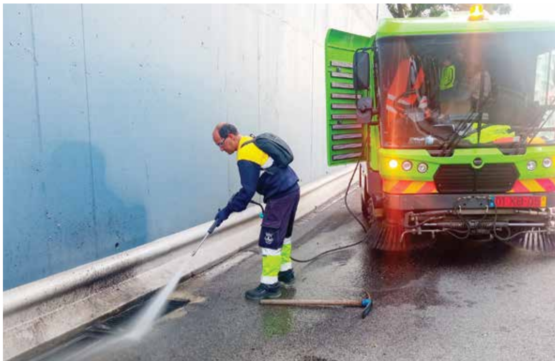
O Túnel do Quebedo foi um dos locais intervencionados nesta operação
